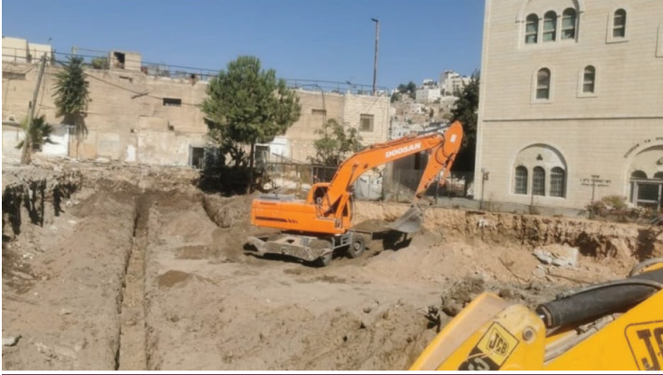
حفريات المستوطنين لإنشاء بؤرة استيطانية في أرج الكراجات
