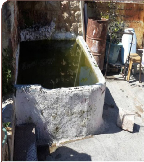
بلاحظ اضافة حوض ماء كبير على اسطح المباني قبل الصيانة
