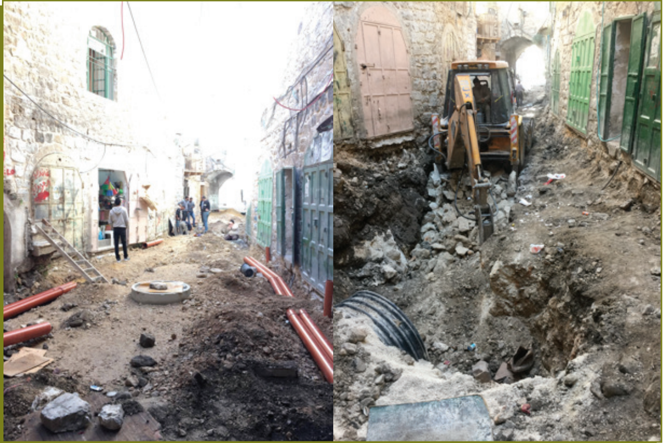
أعمال الحفريات في الشارع
