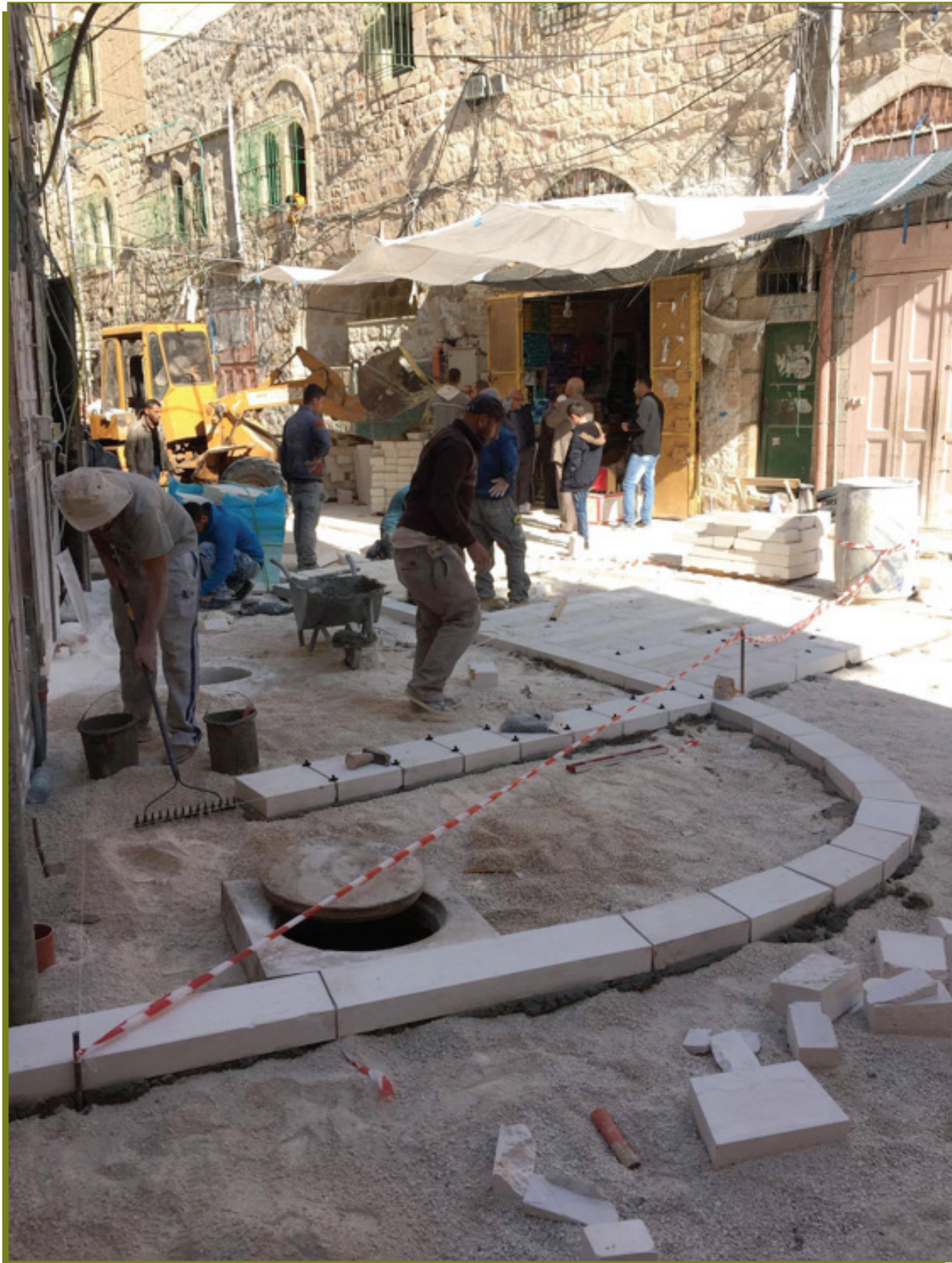
أعمال البلاط الحجري ومصارف المياه
