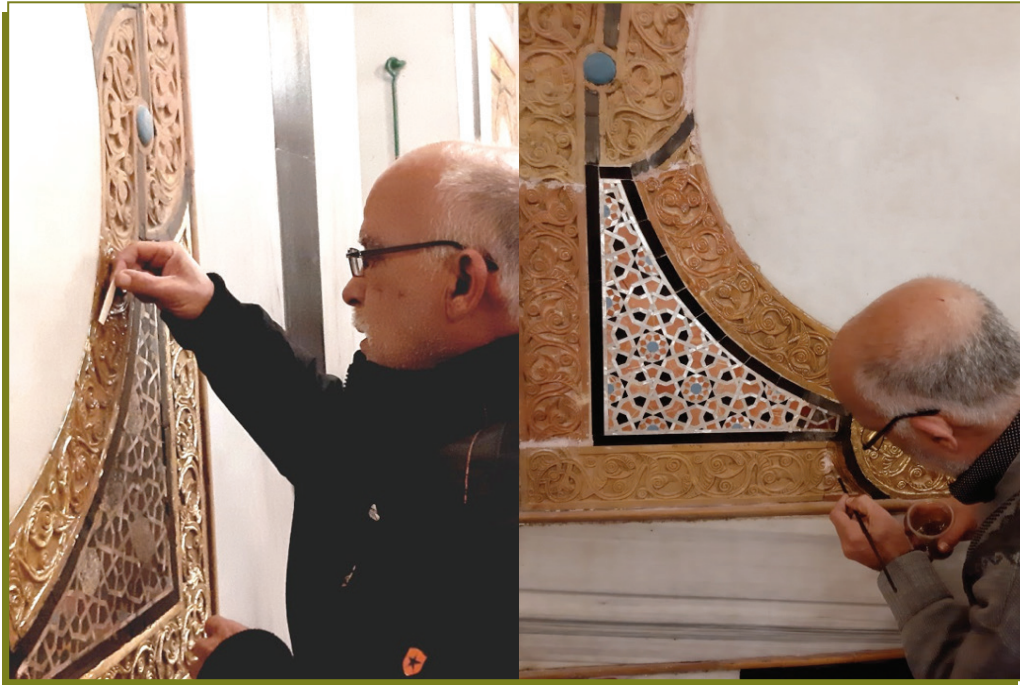
أعمال ترميم الزخارف وتكسيثها بورق الذهب في الإسحاقية
