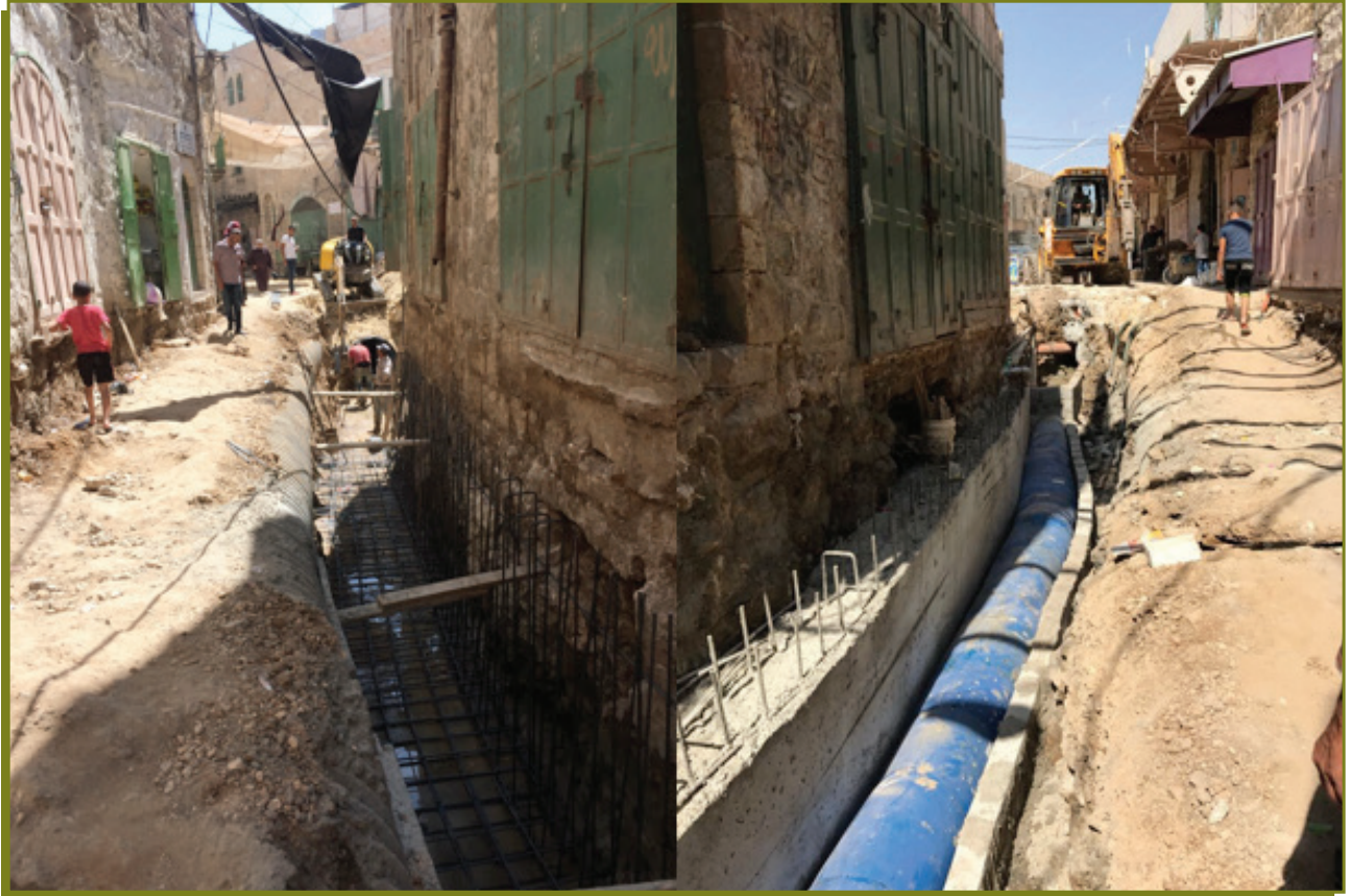
أعمال الحفريات في الشارع
