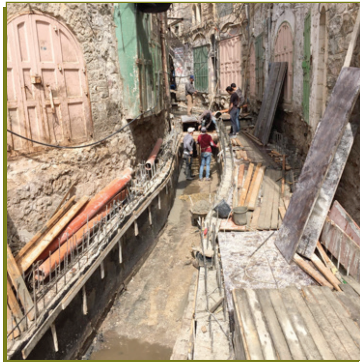
الشارع من جهة مدخل البلدة القديمة (صور أثناء تنفيذ الأعمال)
